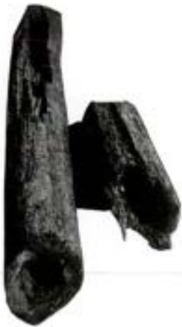
canalisation en bois
