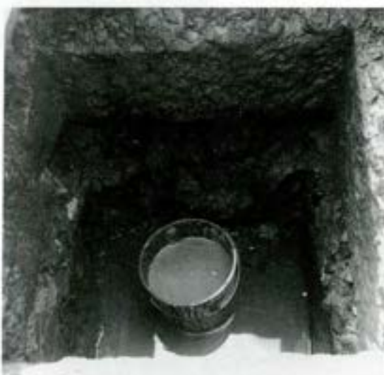
Arrivée d'eau à travers un bérillon de galets
